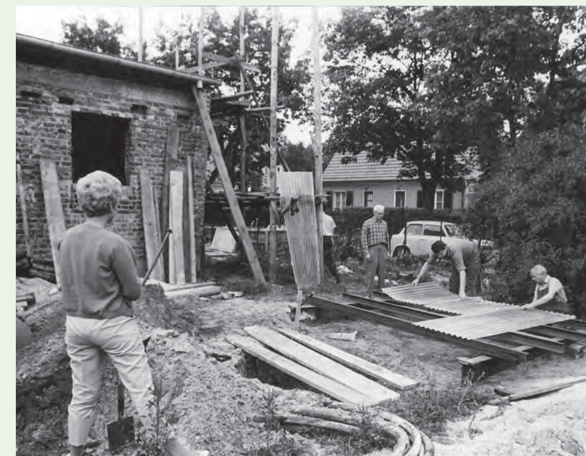
Das Tennisklubhaus Hohen Neuendorf wird gebaut
