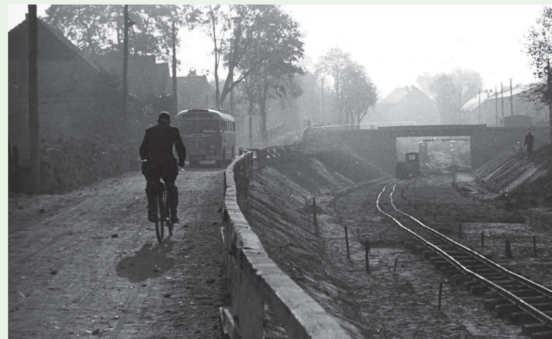
Bau des nördlichen Berliner Außenrings an der Karl-Marx-Straße Hohen Neuendorf
