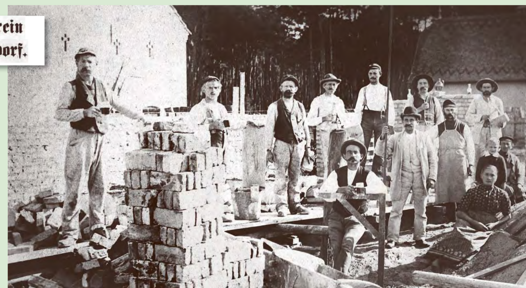
Baustelle am Gasthof „Zur Friedenseiche“ in Alt-Borgsdorf
